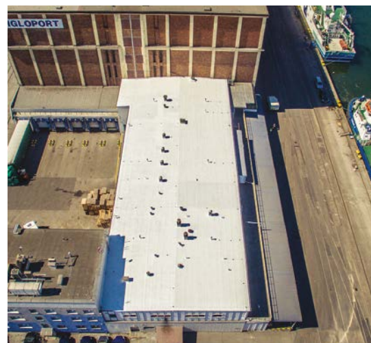
Budynek Iglotex w Gdyni - zastosowanie COOL-R pozwoliło na ograniczenie konieczności stosowania klimatyzacji i znaczne oszczędności
